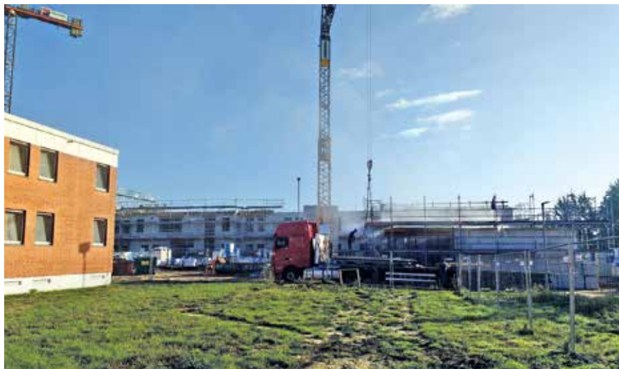
Haus III nimmt Gestalt an.
