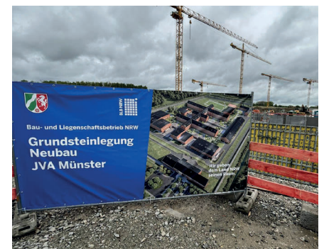
Derzeit wird das Kellergeschoss des Mitteltrakts des Kreuzbaus der Hafthäuser gefertigt.
